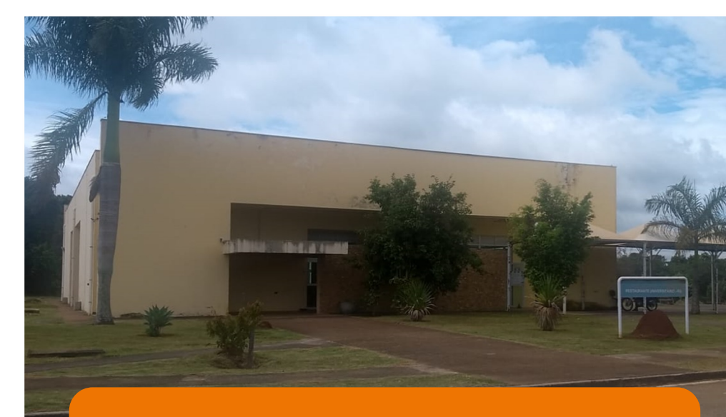
Reforma da cobertura do RU Sorocaba
