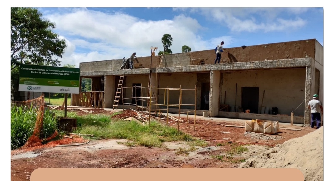
Edifício de Laboratórios Multusuário Lagoa do Sino
