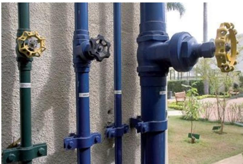
O registro de gaveta é geralmente instalado nos trechos de alimentação, com a função de bloquear ou liberar o fluxo de água, sem necessidade de controle da vazão
